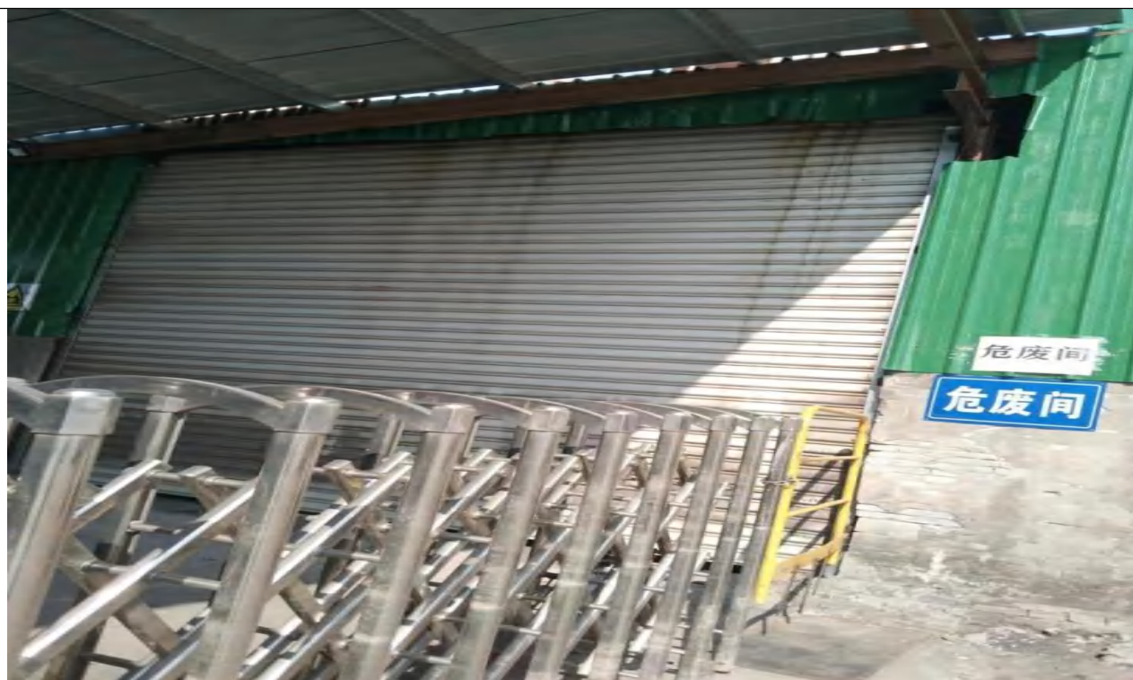
危险废物暂存间
