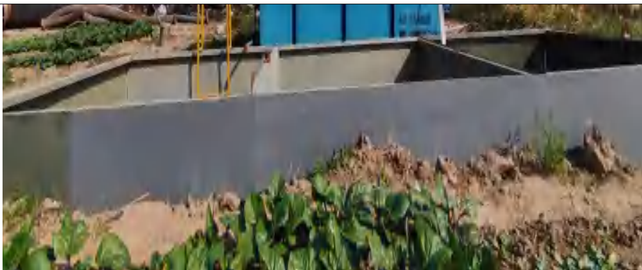
初期雨水收集池
