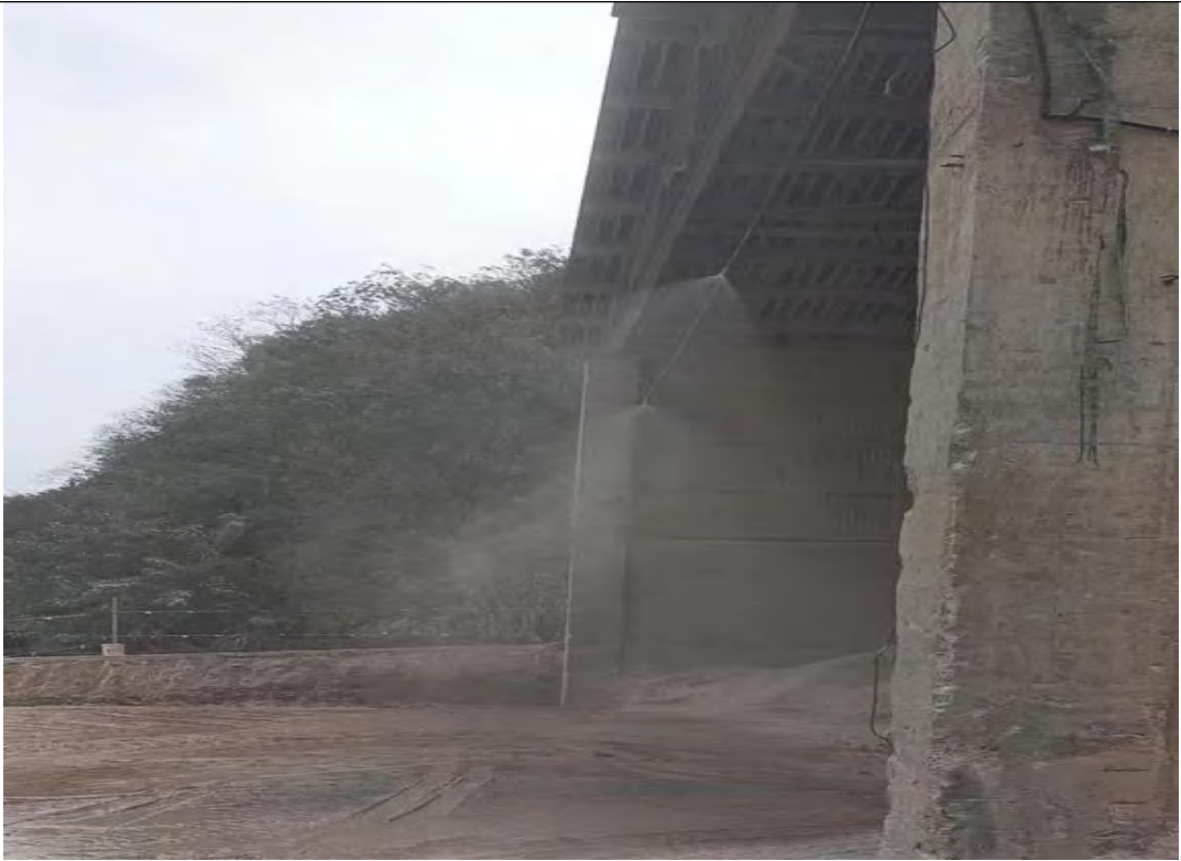
洒水喷雾装置
