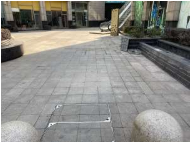
光谷一路污水排口 1#
