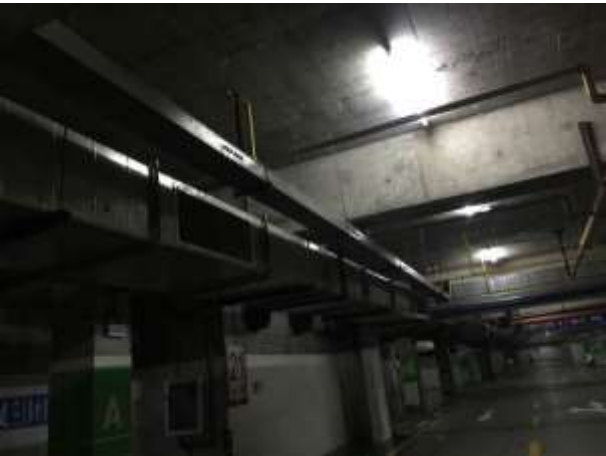
地下室吊装排风管道
