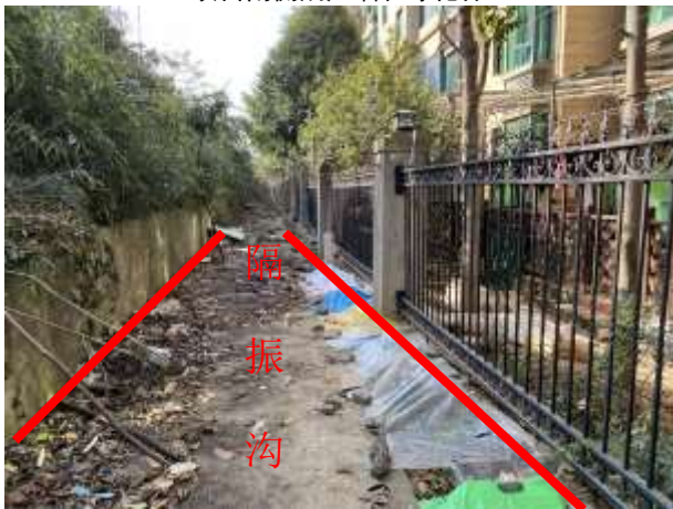
项目南侧隔振沟
