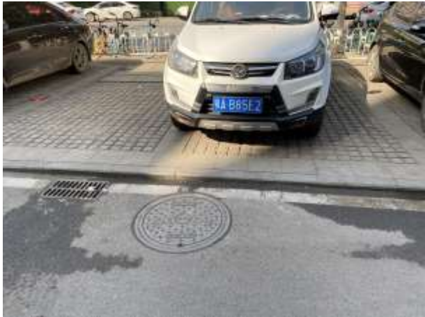
光谷创业街雨水排口 2#
