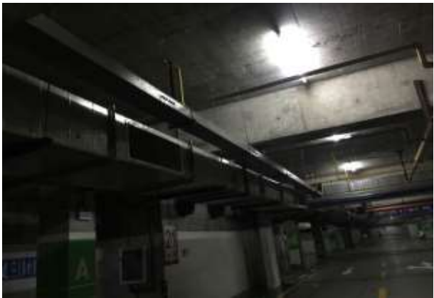
地下室排风管道（吊装）
