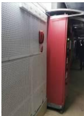
地下室风机房吸声面板
