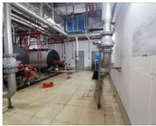
锅炉房的吸声面板
