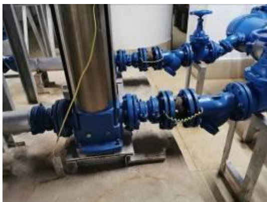
水泵减震垫及软连接
