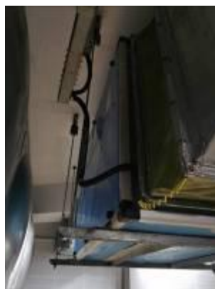
地下室风机的减震弹簧
