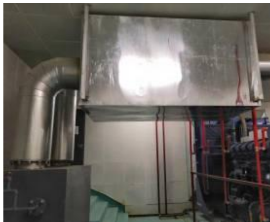
柴油发电机废气处理装置
