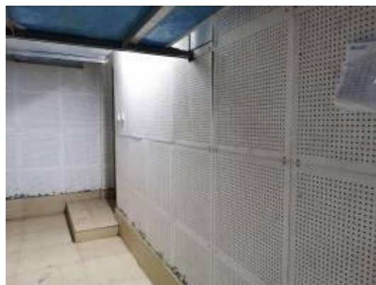
水泵房安的吸声面板
